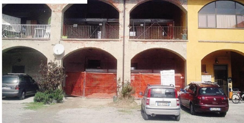
Continuano i lavori alla casa confiscata alla 'ndrangheta
