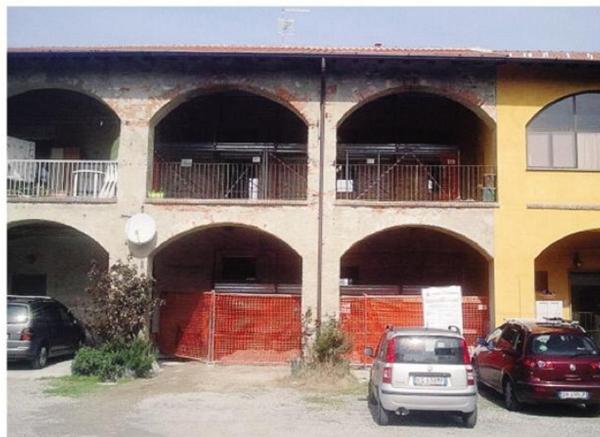
La cascina che fu della famiglia Piromalli ora in ristrutturazione. Ad aprile l'inaugurazione
