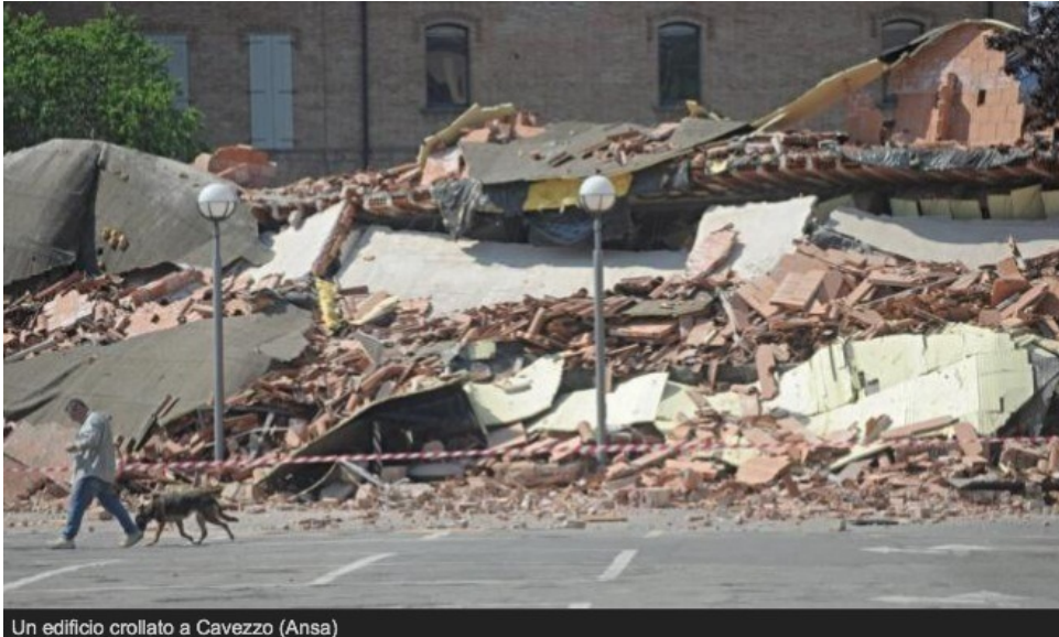
Un edificio crollato a Cavezzo (Ansa)
