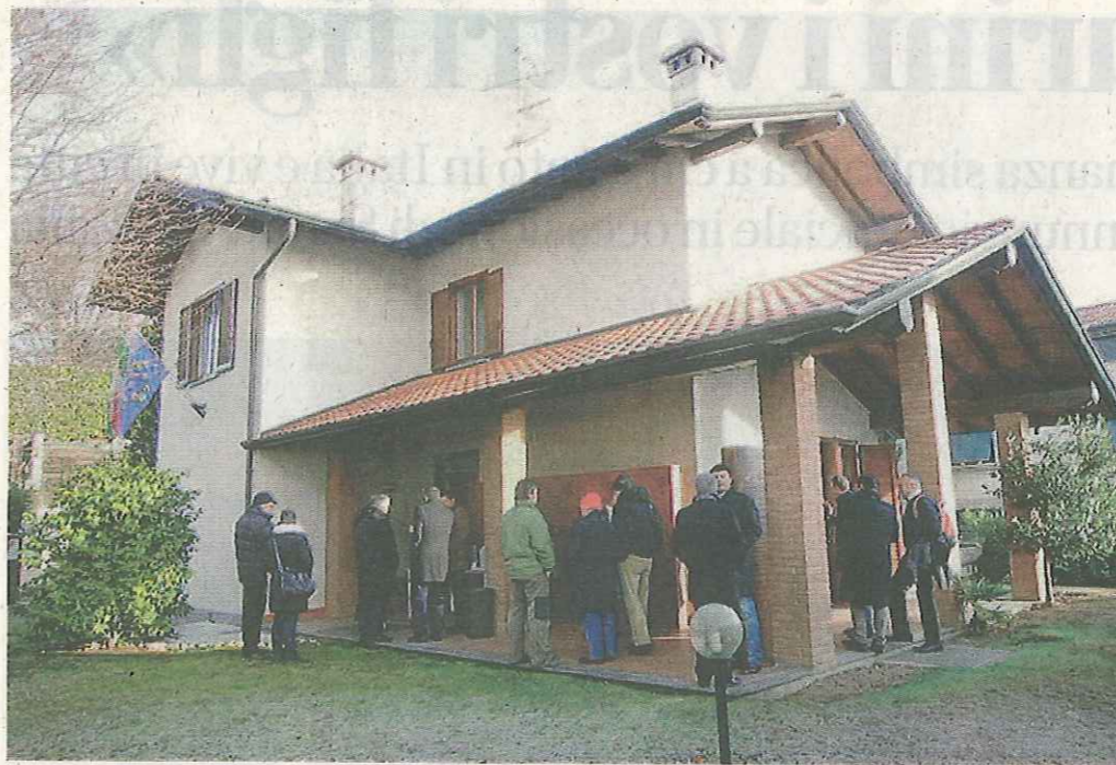
In attesa fuori dalla futura casa della legalità dove sono iniziati i lavori FOTO BARTESAGHI
