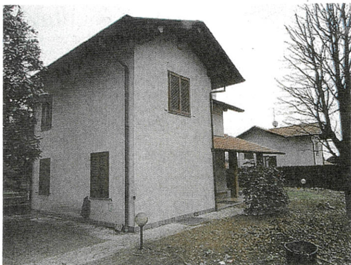
L'immobile di via Di Vittorio dove sorgerà il centro studi
