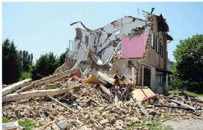
Un edificio crollato: si vigila sulla ricostruzione
