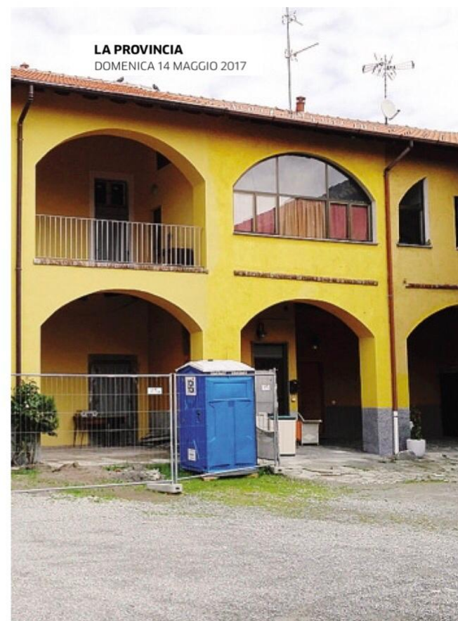
La casa confiscata alla mafia è ancora in fase di completamento
